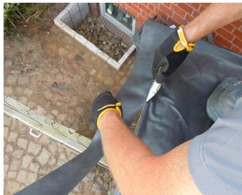
Abschließend erfolgt die Randbefestigung auf den letzten drei Zentimetern. Sie kann mit einem Abdeckprofil oder mithilfe von Kleber ausgeführt werden. Aufgrund der Kapillarwirkung sollte für die Randversiegelung der DACHPROTECT EPDM Anschlusskleber FLEX angewendet werden.
